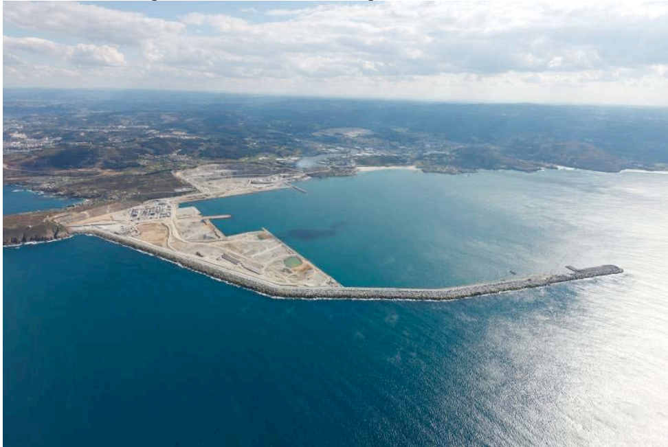
Figura 14. Nueva dársena de Langosteira en construcción
